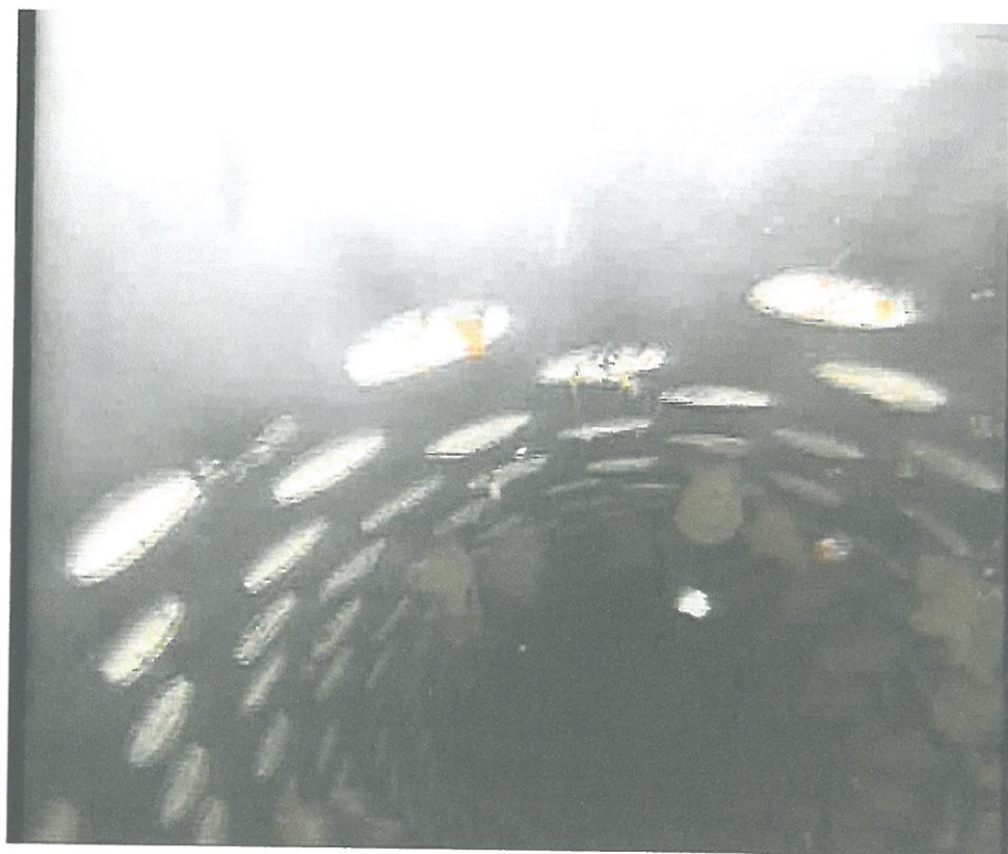
Fot.19. Widok rury filtrowej - głębokość 25,5 m.
