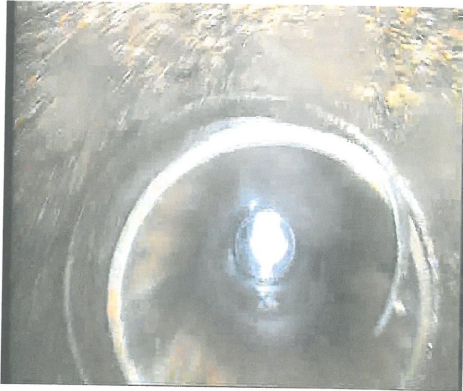
Fot.1. Widok rury studziennej.
